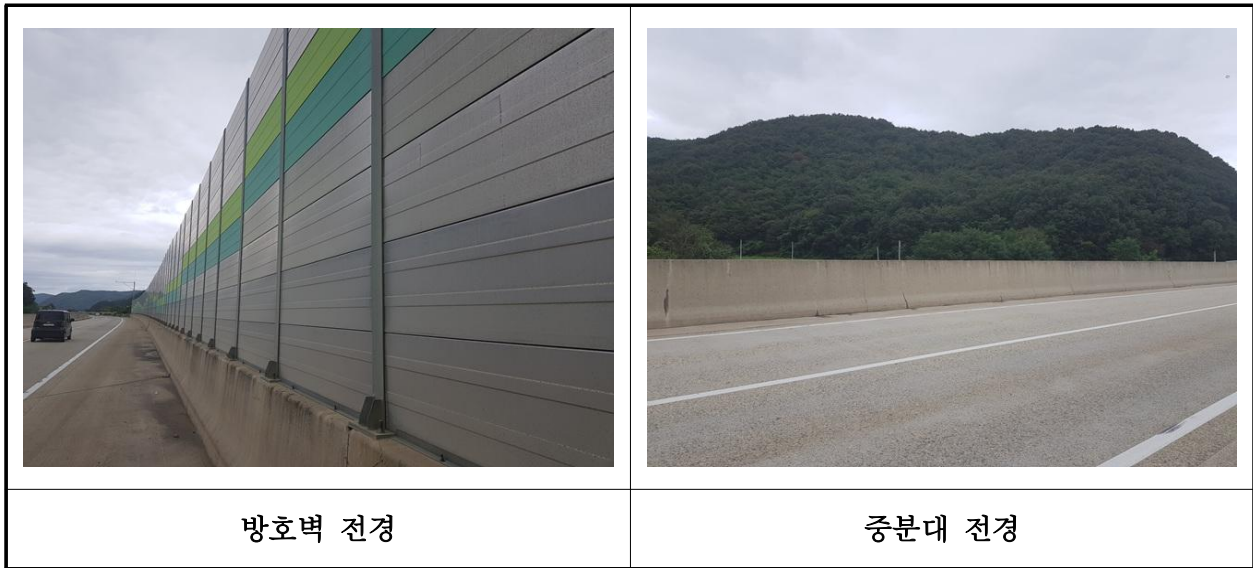
【사진 18.3.24】 방호벽 및 중앙분리대 전경
