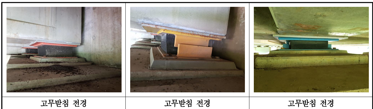
【사진 18.3.40】 교량받침 전경
