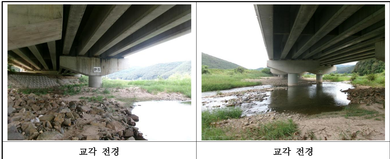
【사진 18.3.10】 교각 전경
