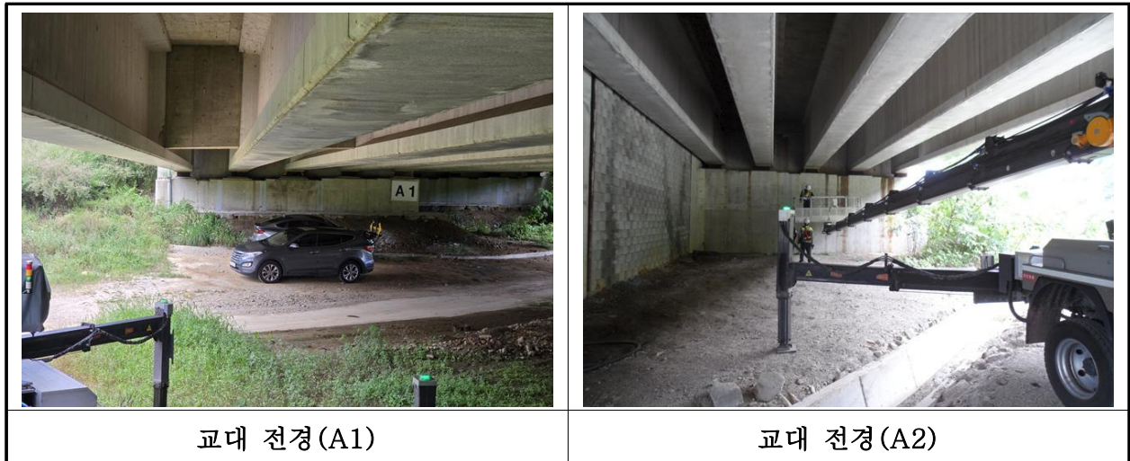
【사진 18.3.35】 교대 전경
