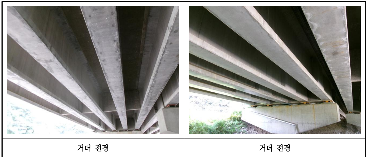
【사진 18.3.31】 거더 전경
