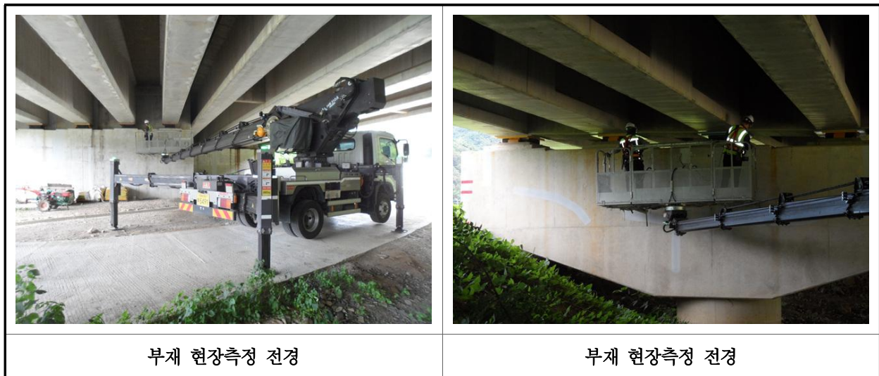
【사진 18.2.1】 부재 현장측정 전경
