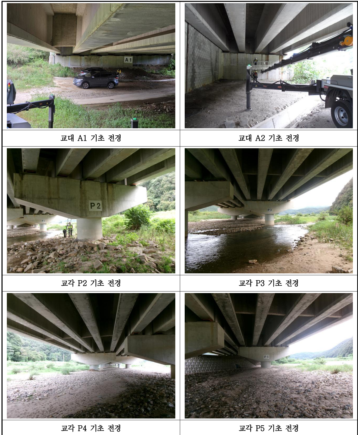
【사진 18.3.39】 기초 전경
