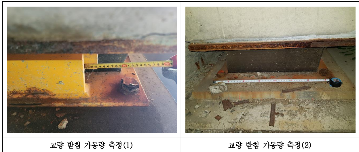
【사진 18.3.16】 교량받침 이동량 측정
