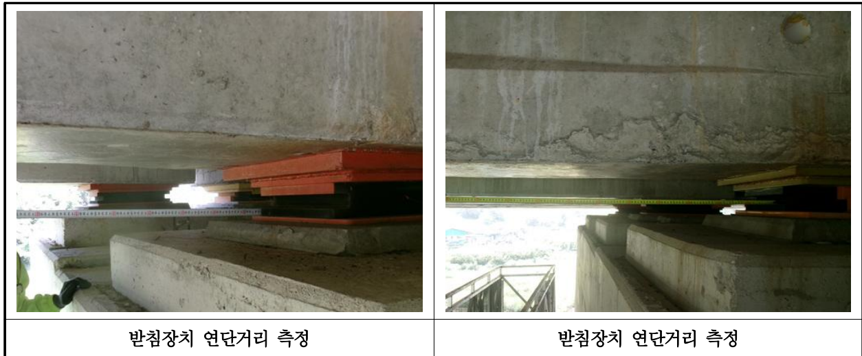
【사진 18.3.15】 교량반침장치 연단거리측정
