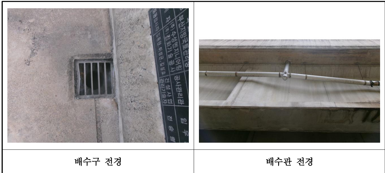
【사진 18.3.49】 배수시설 전경
