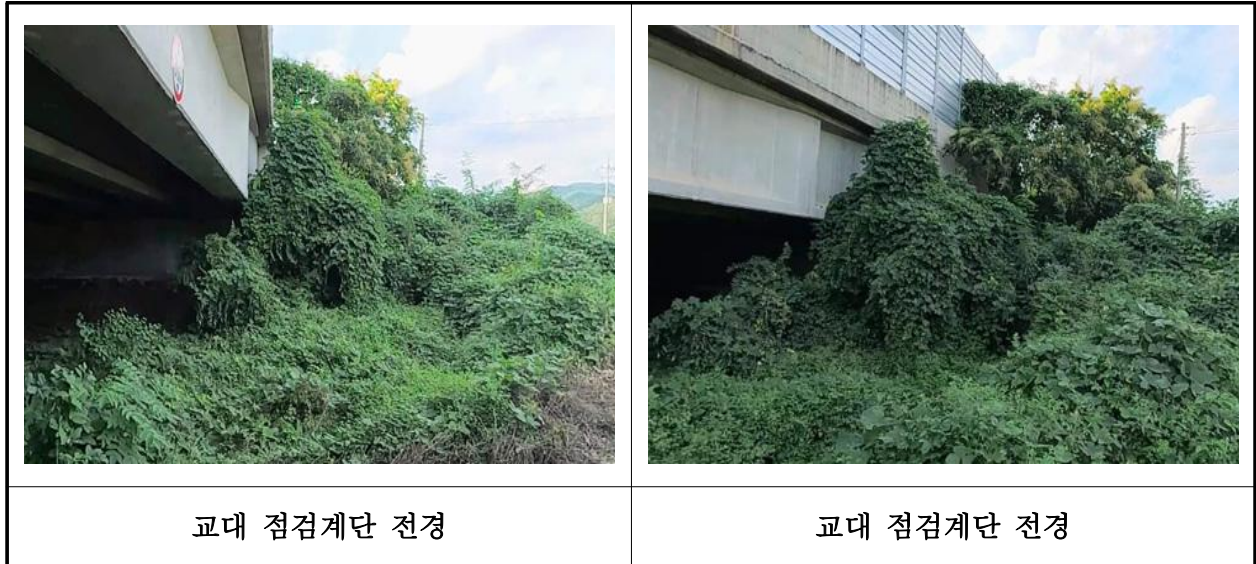
【사진 18.3.26】 교량 점검시설 전경
