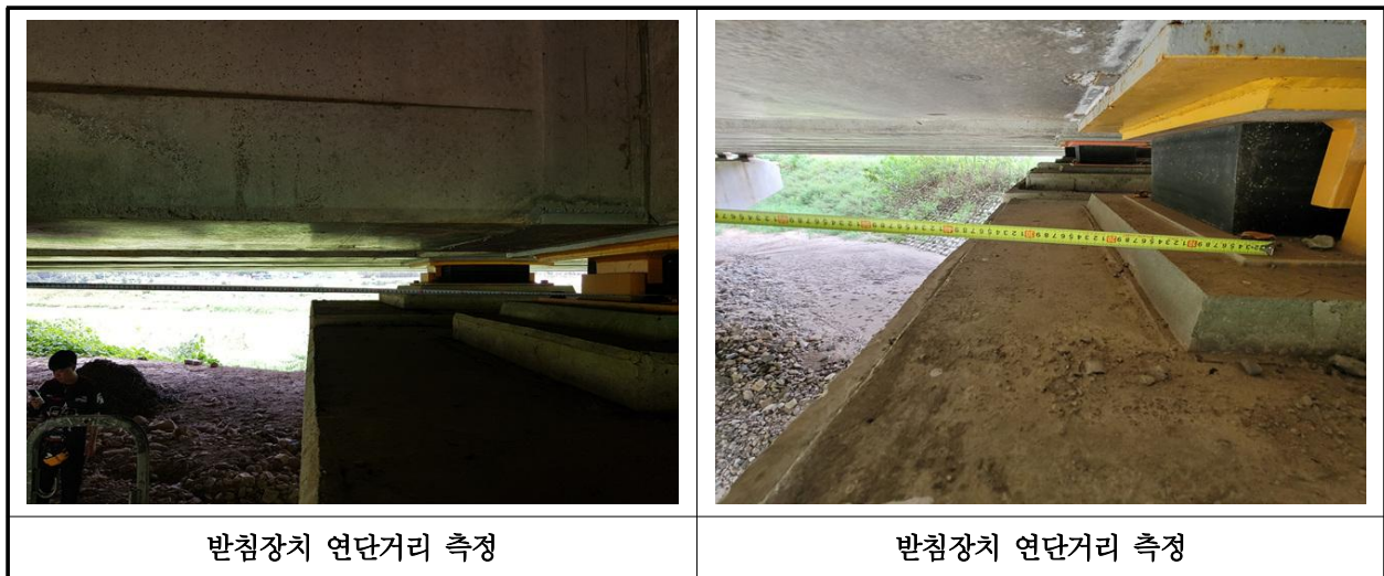
【사진 18.3.42】 교량받침장치 연단거리측정
