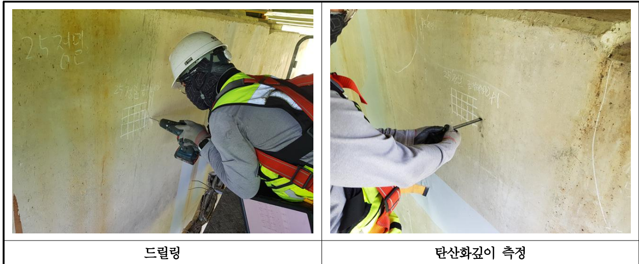
【사진 18.4.3】 탄산화 깊이 측정 현장사진
