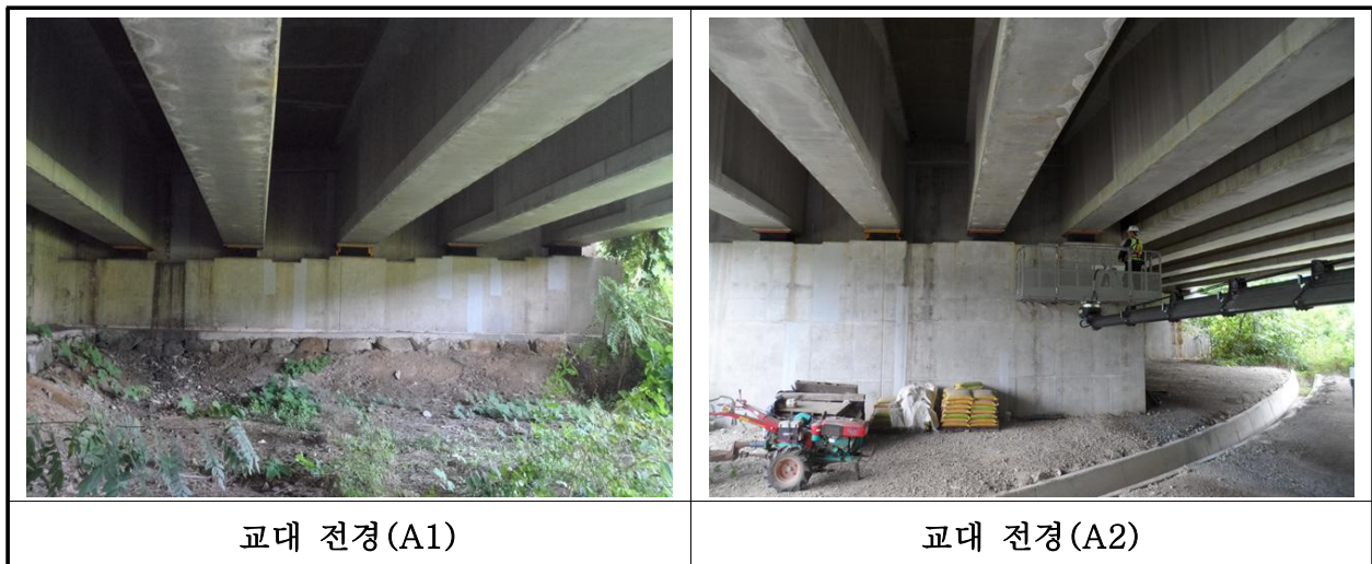
【사진 18.3.8】 교대 전경
