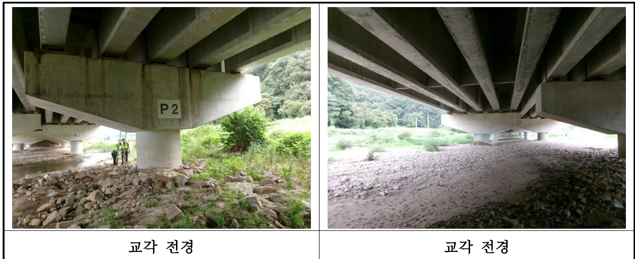
【사진 18.3.37】 교각 전경
