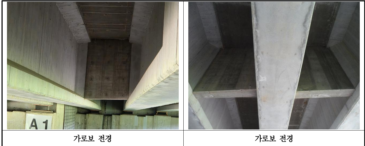
【사진 18.3.6】 가로보 전경
