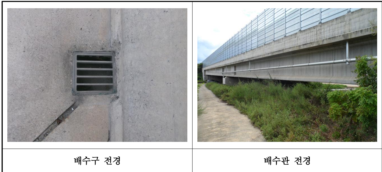
【사진 18.3.22】 배수시설 전경
